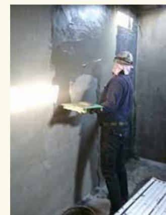
サンエーシートを標準施工しモルタルを 10mm 打設、7日間養生後、引張接着強度試験を実施
