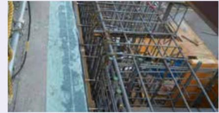
天端コンクリートにサンエーシートを張り掛け後、養生をしている状態
