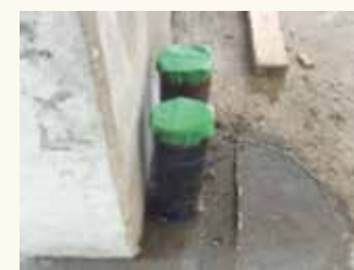
立上りに近く配管同士が隣接
