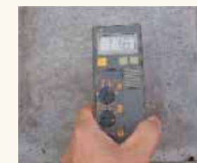
コンクリート打設3日後
