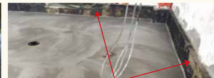
既存防水層（撤去もしくは下地調整材塗布）
