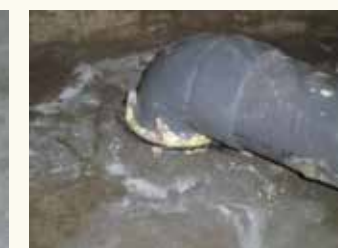
床から直接エルボ継手設置は避ける
