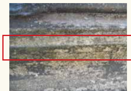
立上りシート端部も全く剥がれや浮きなどはありませんでした。
